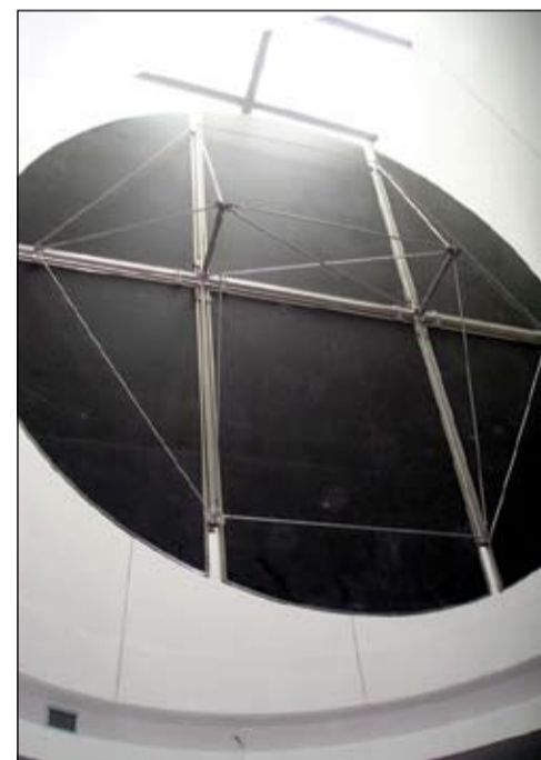
Regulace osvětlení clonou světlíku
